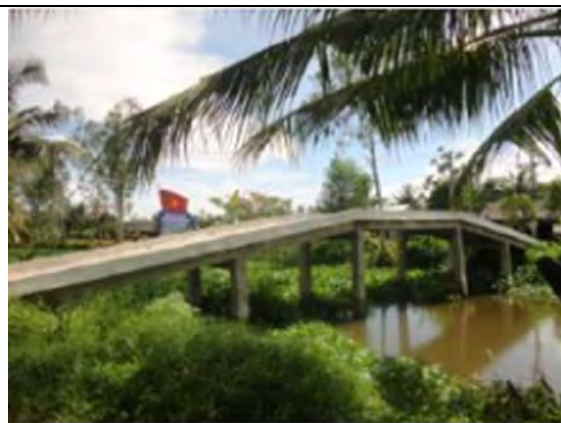
Hình 1: Cầu bắc qua ấp 6, xã Thuận Hưng, LM
