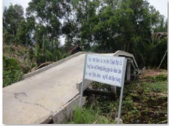
Hình: cầu kênh 9, xã Lương Nghĩa, LM
